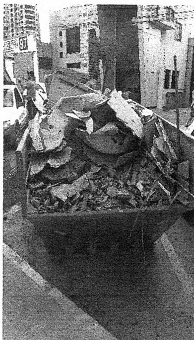
Caçamba para remoção de resíduos
